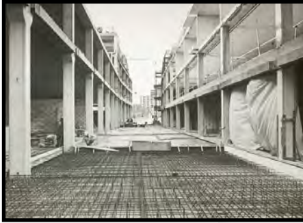
Bouw van fundering Westwaarts
