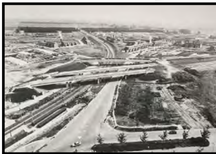
Aanleg Aziëweg met kruising Gaardedreef
