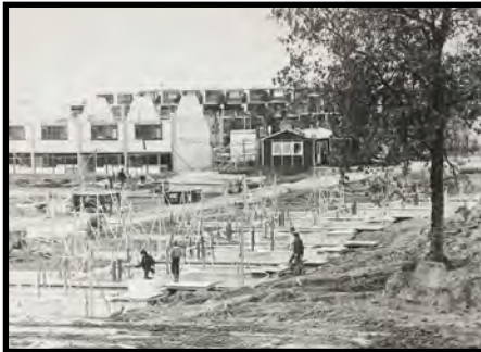
Buytenwegh in aanbouw
